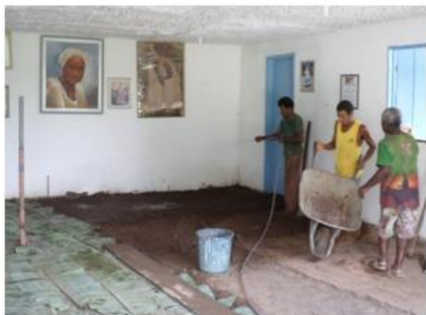
Fig. 07. Piso sendo molhado com o auxílio de uma mangueira. Fonte: Matos(2016).
