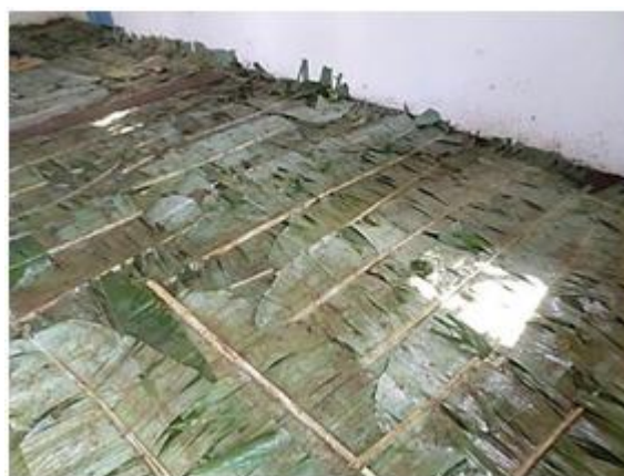
Fig. 12. Secagem do piso. Fonte: Matos (2016).
