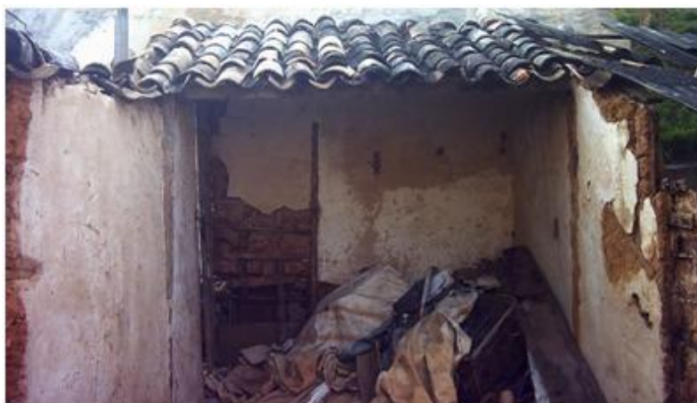
Fig. 21 - Reminiscência de casa construída com a técnica da taipa de mão. Fonte: Ramos (2013)
