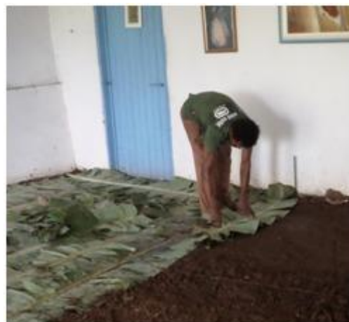
Fig. 08. Piso sendo coberto com folhas de bananeira. Fonte: Matos(2016).
