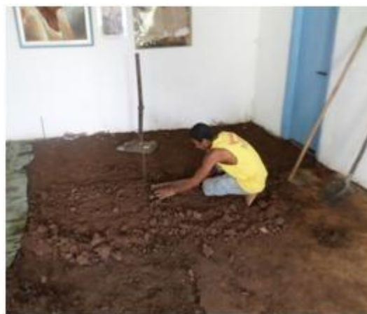
Fig. 04. Nivelamento com sarrafo de madeira. Fonte: Matos(2016).
