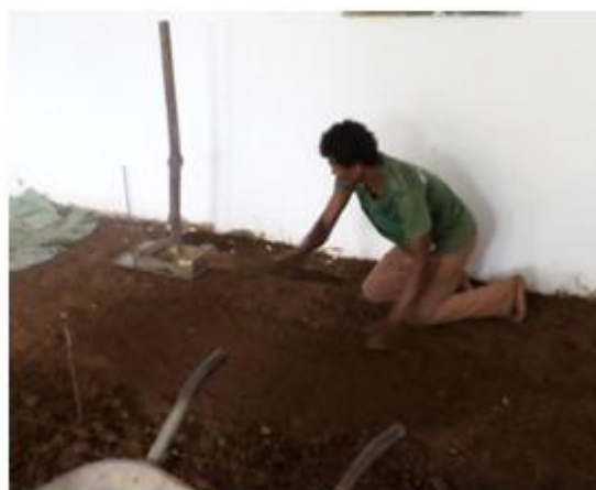
Fig. 06. Aplicação da camada fina de barro. Foto: Matos(2016).
