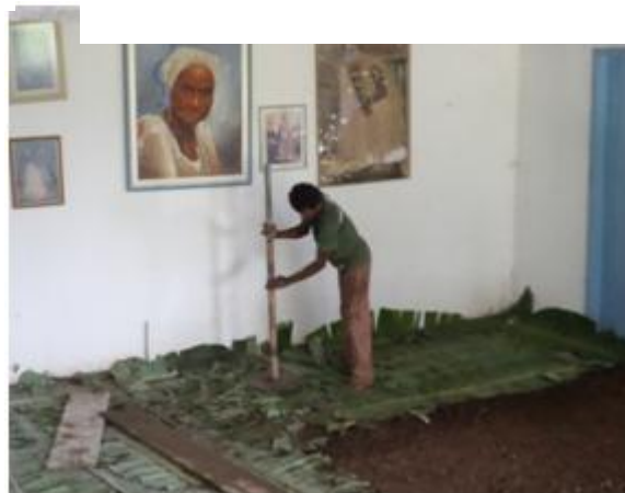
Fig. 10. Compactação do barro. Fonte: Matos(2016).
