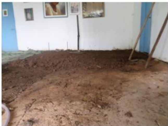
Fig. 01 - Supressão do piso antigo do abassá Fonte: Matos (2016)
