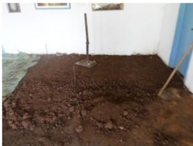
Fig. 02 - Lançamento do barro no solo Fonte: Matos (2016)
