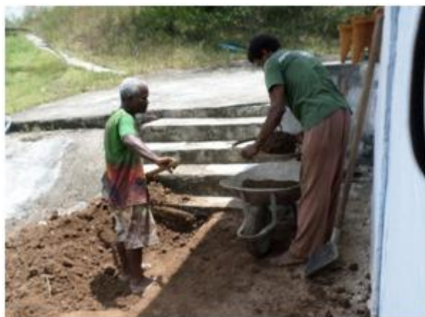
Fig. 05. Barro sendo peneirado para a adição da camada fina. Fonte: Matos(2016).
