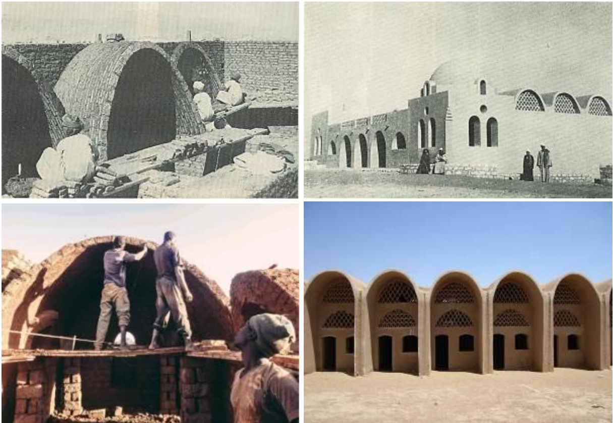
Figura 3 - Construção de abóbadas com adobes pelos núbios; Mercado em Nova Gurna, no Egito; Construção de abóbadas com adobes pelos senegaleses; Hassan Fathy Village (da esquerda para direita) (Fathy, 1980); (Paquier, 2015)
